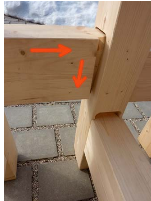
Zapfen leicht geneigt in Zapfenloch einführen
