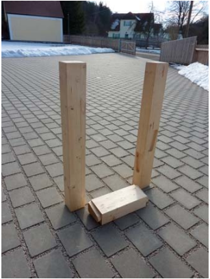
Kantholz-Rungen auf planen Boden stellen
