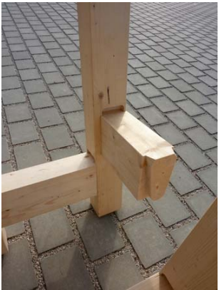
hinteres Koppelstück (kurz) einhängen
