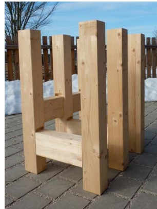
Verbindungen leicht spannen (anklopfen)
